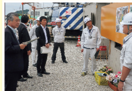
国分川地震高潮対策工事にて
